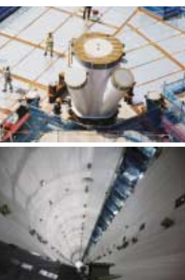
東京スカイツリーの地上1本目の鉄骨柱（上）とシャフト内部の現在の様子（提供：大林組）
